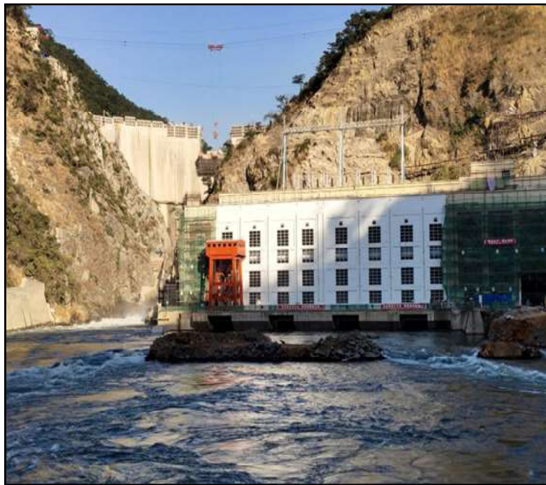
Une vue partielle de la centrale hydroélectrique de Busanga
