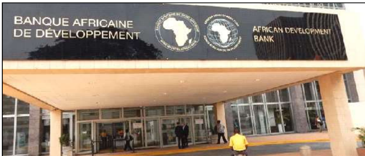
Siège de la BAD à Abidjan (Côte d'Ivoire)
