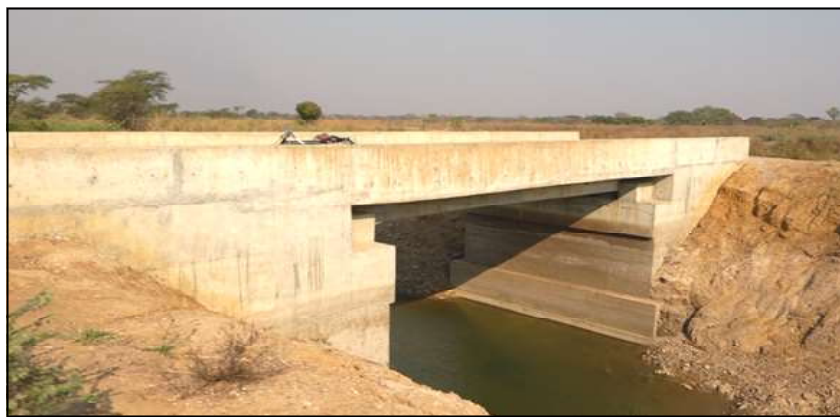
Un pont jeté sur la route par KIPAY Energy pour faciliter le transport des engins.
