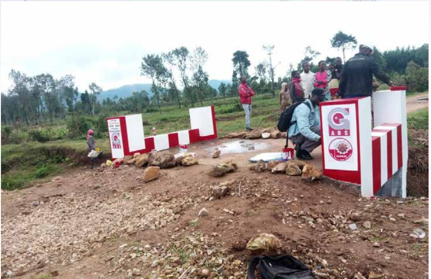
Construction d'un pont dans le territoire de Walungu. (Photo Droits Tiers).
