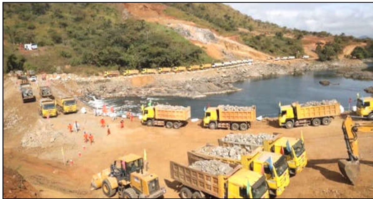
Déploiement des engins sur le site du barrage de Caculo Cabaça, en Angola.
