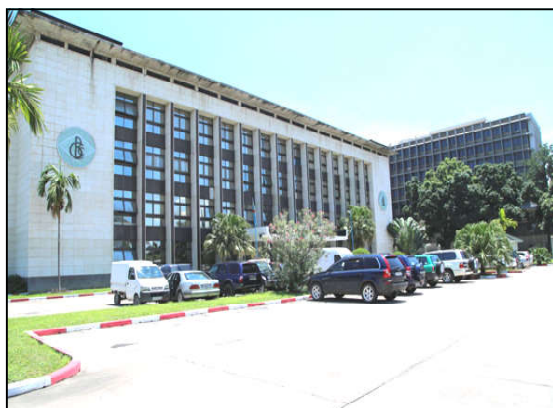
Façade d'entrée du siège social de la BCC à Kinshasa
