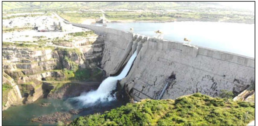
L'imposante centrale hydroélectrique de Laúca, en Angola
