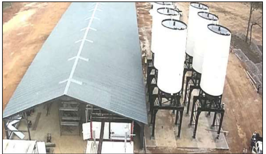
Vue partielle des installations de COMIDE
